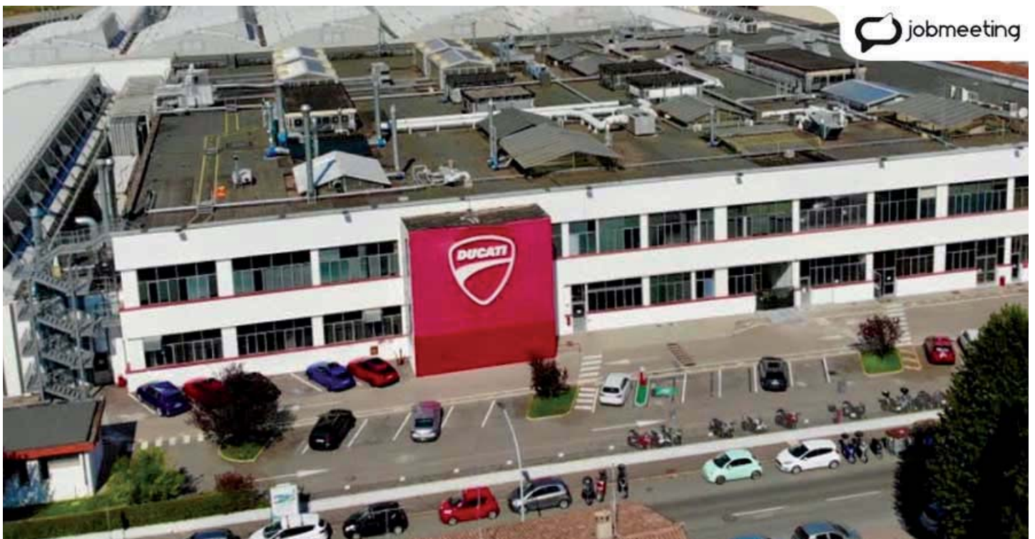
Borgo Panigale, edificio della fabbrica italiana Ducati
